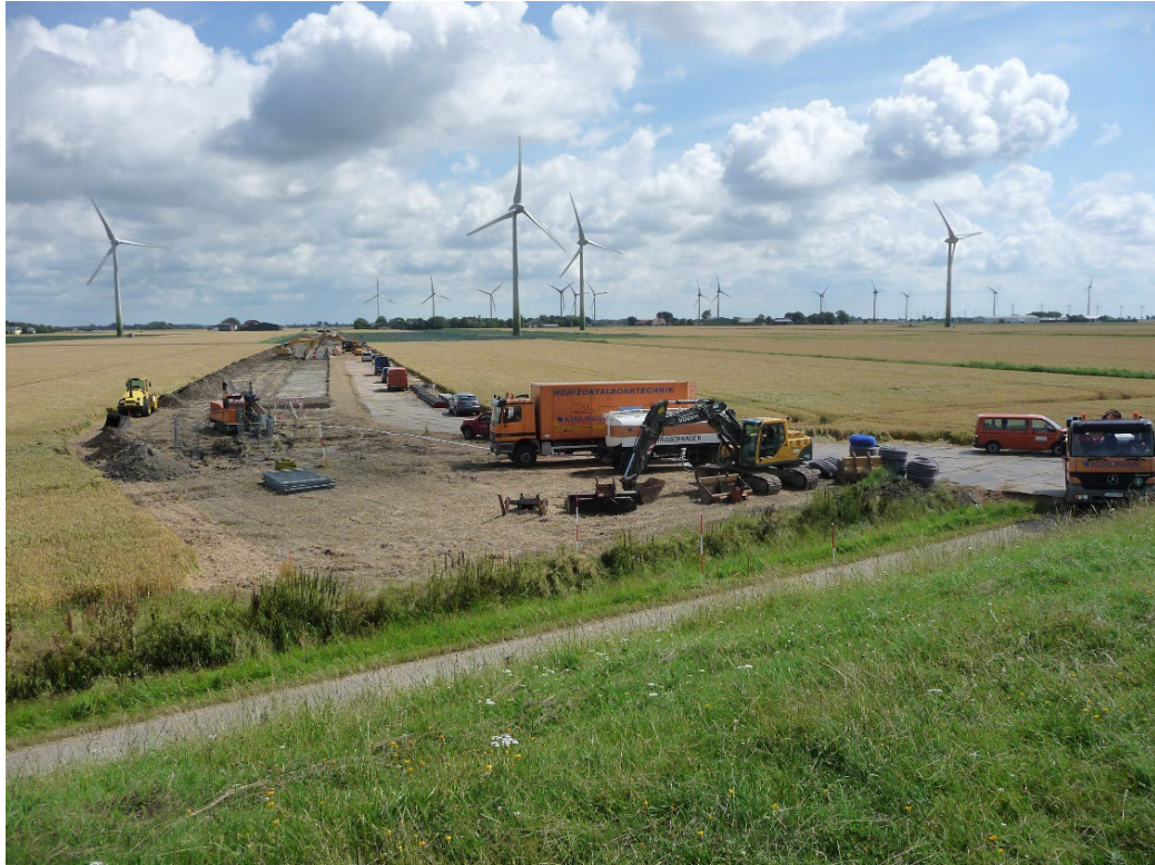
Foto 1: 110-kV-Kabelbaustelle Dieksanderkoog-Marne/West, Schleswig-Holstein Netz AG (Beispielfoto, Quelle: Fa. Omexom)
